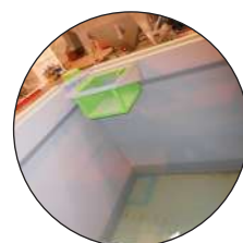
Bac de pré-décantation
