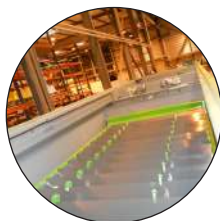
Décanteur lamellaire
