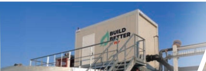
**01** Local technique, regroupant l'unité de préparation et de dosage de floculant, ainsi que l'armoire électrique
